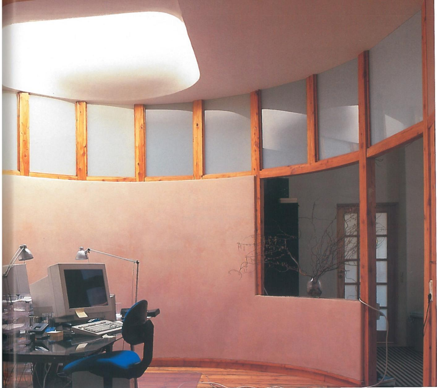
Die gebogenen Trennwände im Gebäudeinneren sind gestalterischer Blickfang. Durch Heizschlangen im Inneren und Lehmputz tragen sie zu einem behaglichen Raumklima bei.
