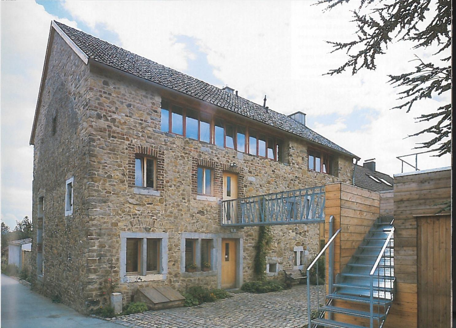
*Das historische Außenmauerwerk ist ein inhomogenes Zyklopenmauerwerk, bestehend aus Grauwacke und anderen in der Umgebung verfügbaren Steinen. Vermörtelt wurden sie mit Kalk und Lehmörtel. Die Wandstärken betragen zwischen 50 und 70 cm.*
