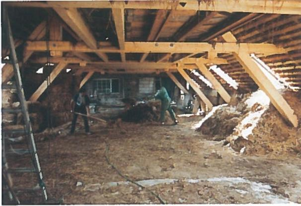
Für die Dämmung der Dachfläche wurde Stroh aus biologisch-dynamischem Anbau verwandt, das mit Lehmschlämme über mehrere Tage getränkt wurde.
