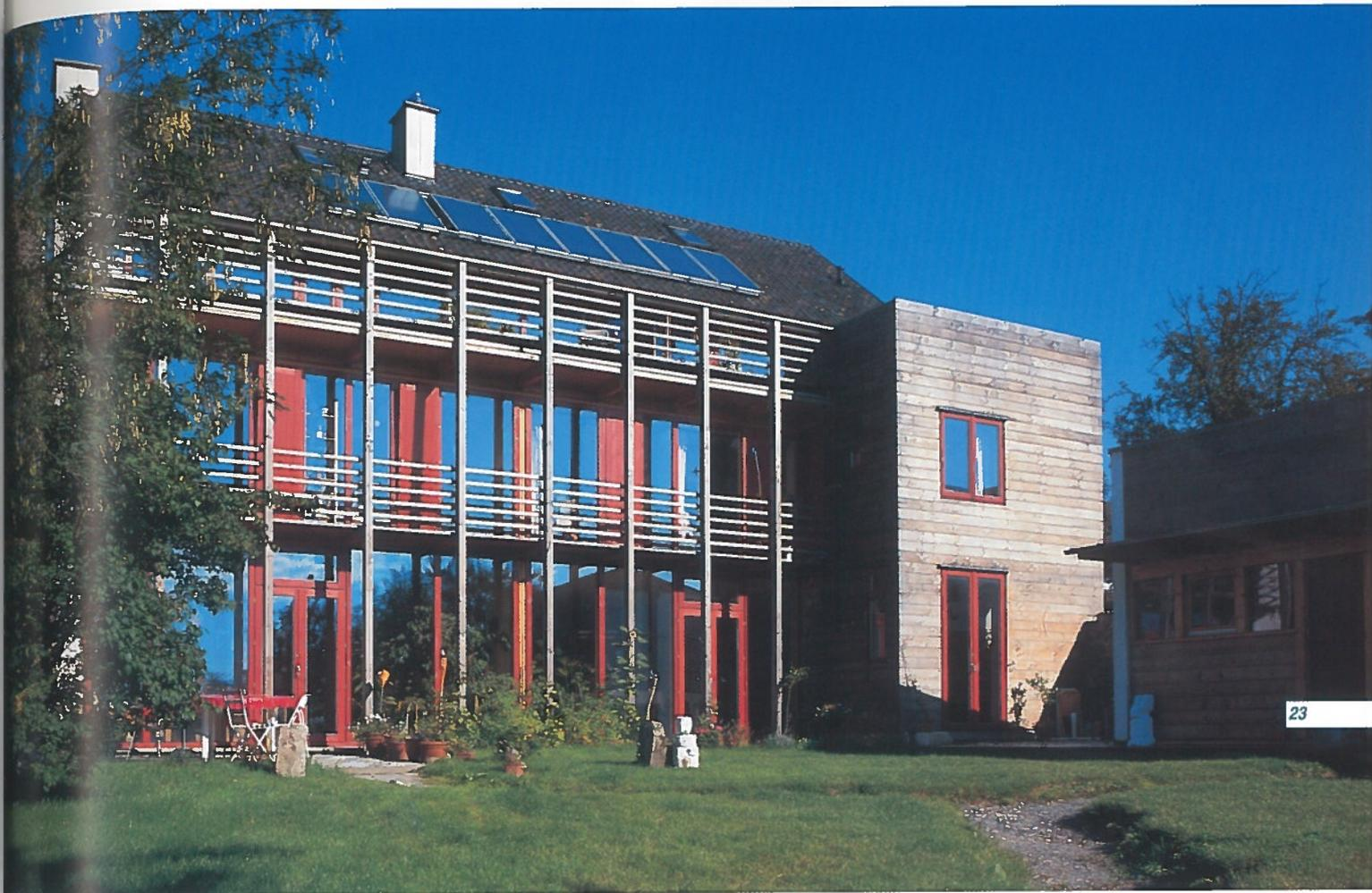
Die Südfassade ist für ein Wohnen mit der Sonne entwickelt worden. Im Winter fällt die niedrig stehende Sonne tief in das Gebäude ein und erwärmt die Südräume. Die Lüftungsanlage bringt einen Teil dieser Wärme auch auf die Gebäudenordseite. Im Sommer verschattet der vorge-lagerte Balkon die Fassade und schützt so das Gebäude vor Überhitzung durch die hochste-hende Sonne.
