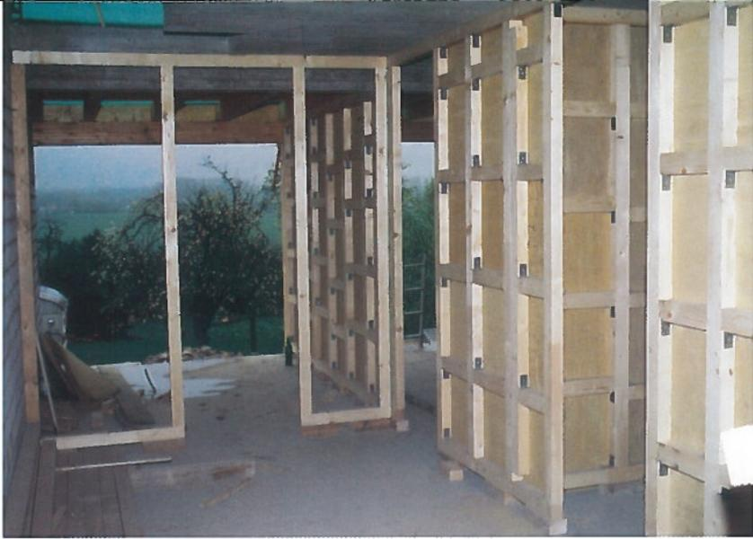
Leichte Trennwände aus nachwachsenden Rohstoffen: Holzständerwände, später ausgefacht mit Zelluloseplatten, bekleidet mit Lehmputz.
