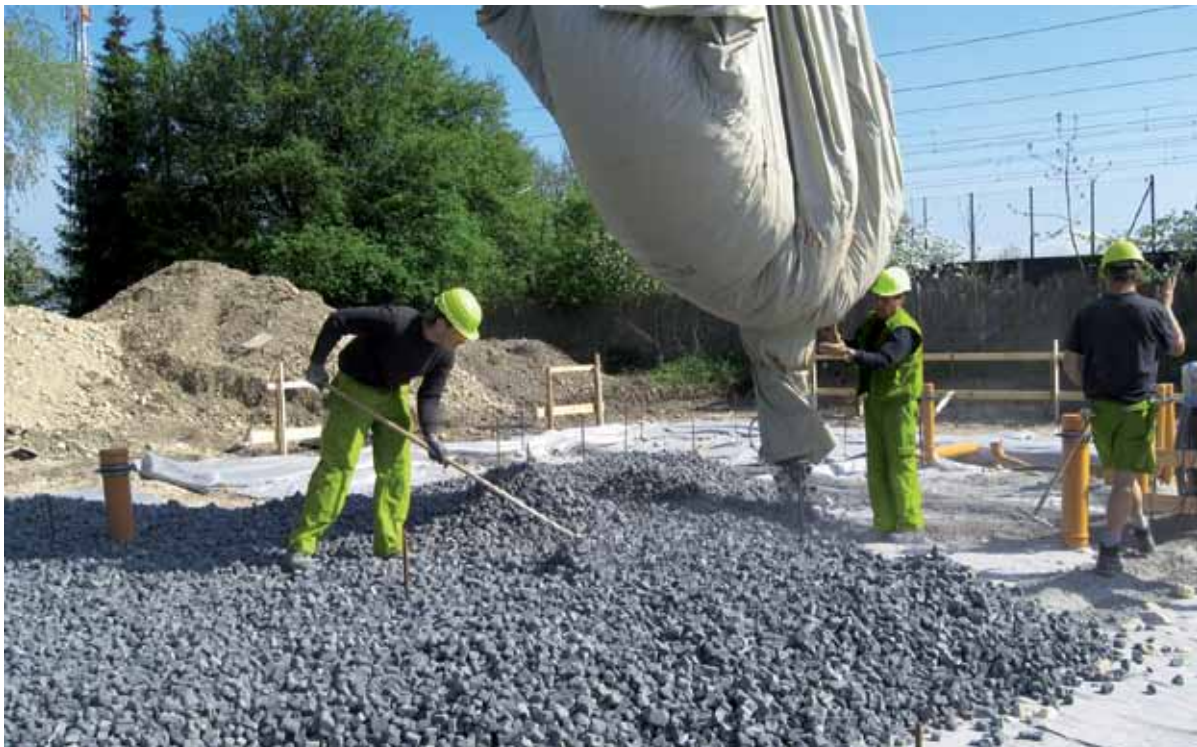
Abbildung 17: Mit Glasschaumschotter lassen sich lastabtragende Dämmungen herstellen, sodass gegebenenfalls auf ressourcenintensive Fundamentplatten verzichtet werden kann.
