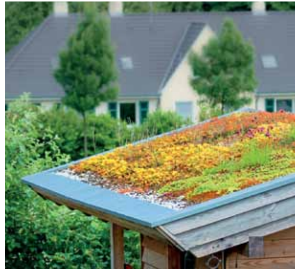
Abbildung 27: Gründach auf einem Nebengebäude
