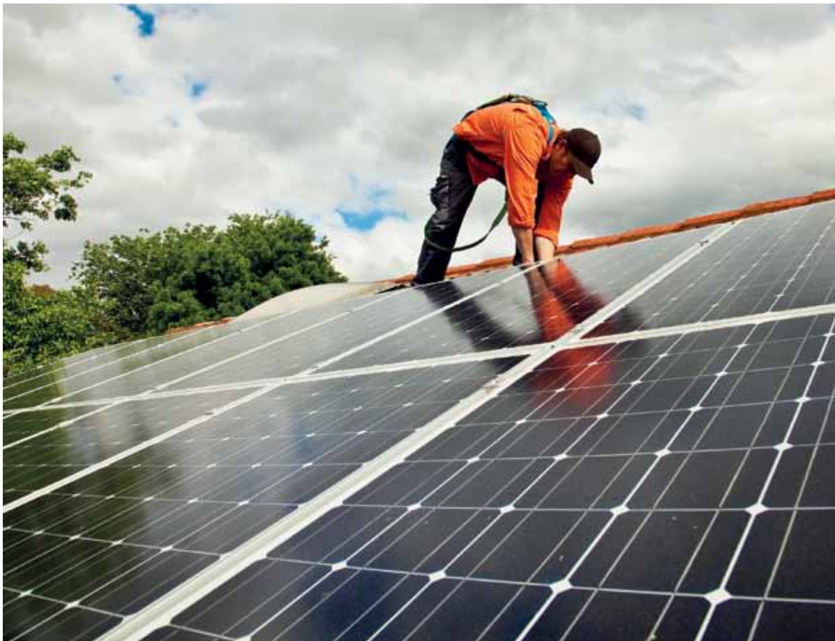
Abbildung 41: Montage einer Photovoltaik-Anlage auf einem Dach
