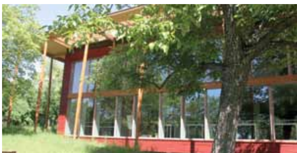
Abbildung 20: Einfache Fenster unterstützen eine moderne und schlichte Architektur.
