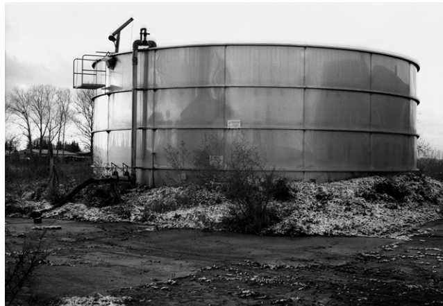
Eine ausrangierte Biogasanlage auf dem Gelände einer ehemaligen LPG in Brandenburg.
