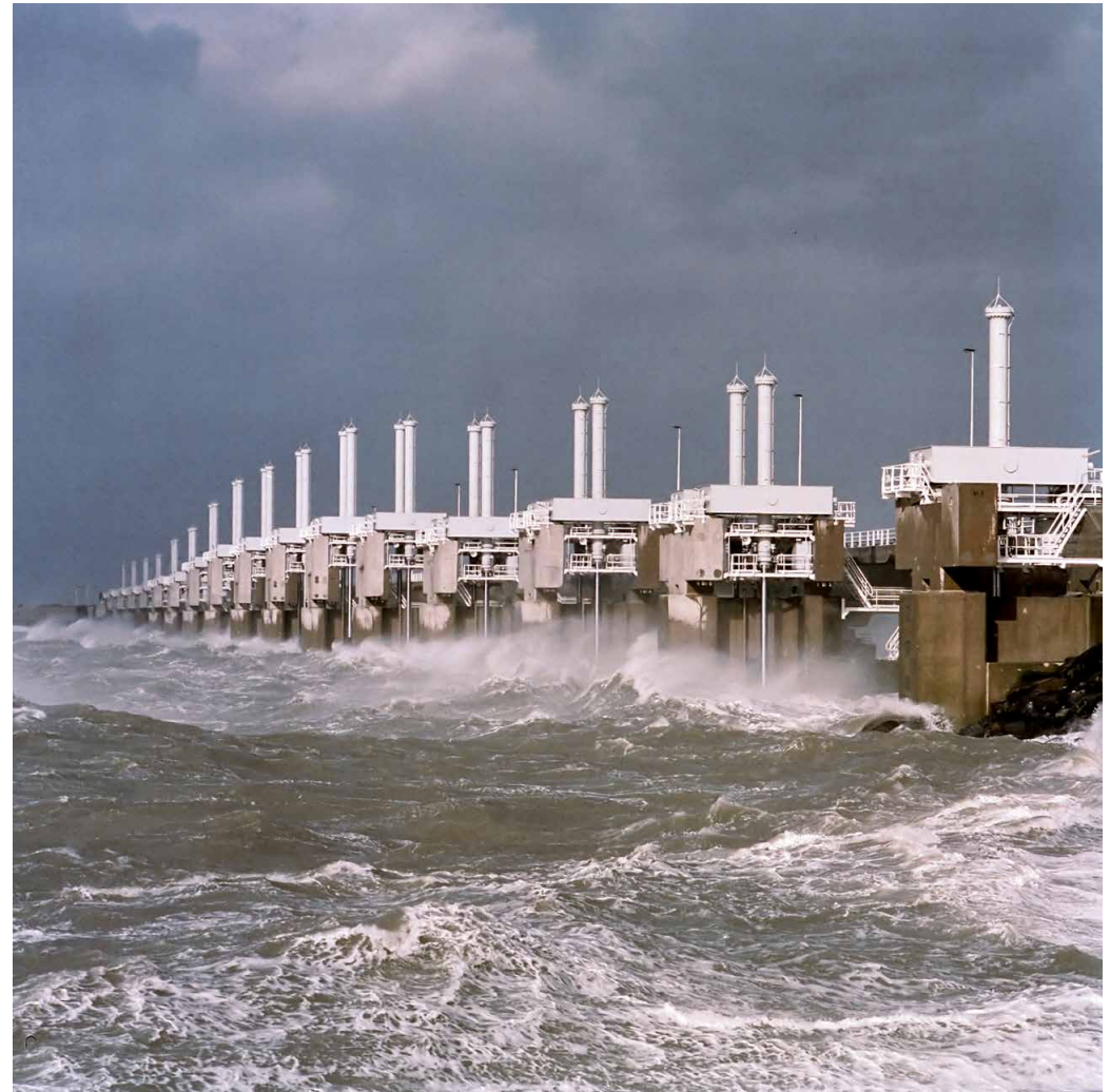
Das Oosterschelde-Sturmflutwehr (niederländisch Oosterscheldekering) ist wie das Maeslant-Sturmflutwehr Teil der Deltawerke, die hauptsächlich in der niederländischen Provinz Zeeland vor Sturmfluten und Hochwasser schützen sollen. Das Bauwerk, teils Deich und teils Wehr, wurde zwischen den Inseln Schouwen-Duiveland und Noord-Beveland errichtet (Wikipedia). Foto: Rens Jacobs / Beeldbank V&W via Wikimedia Commons
