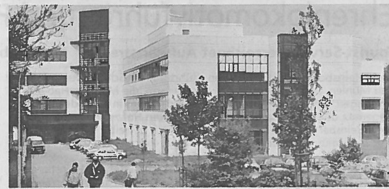
Deutliche Einsparungen im Energiebereich, das heißt auch Kostensenkung, wurden an diesem Gebäude der Fachhochschule Aachen erreicht.
