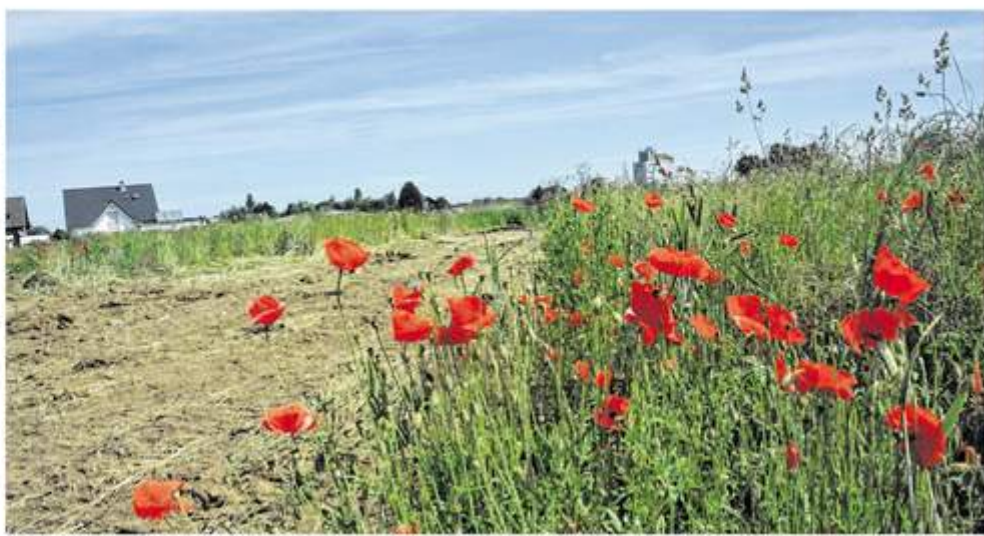
Noch blüht der Klatschmohn auf einem Teil des Baugebiets. Die ersten Baustraßen werden allerdings schon angelegt: Hier, zwischen Sebastianus- und Friedrich-Ebert-Straße – entstehen die „Neuen Höfe Dürwiß“, ein bislang deutschlandweit einzigartiges Siedlungsprojekt. Fotos: Rudolf Müller
