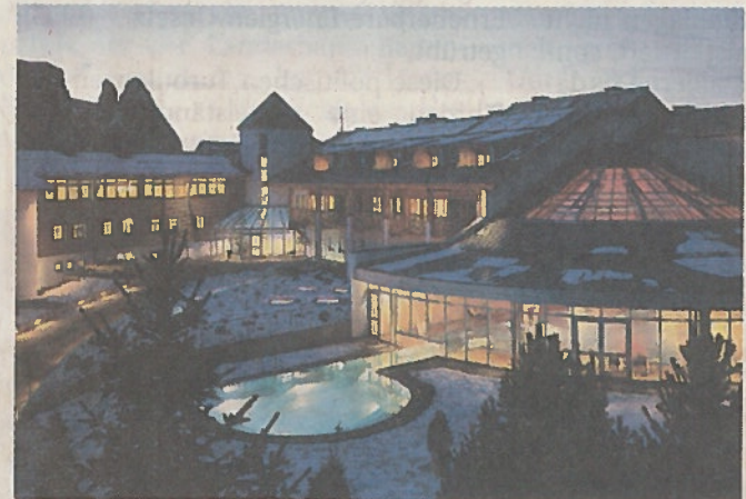
Alles Holz - links ein Teil des Rohbaus, rechts der fertig gestellte Hotelkomplex auf der Seiseralm aus „Holz100“. Foto (2): Aachener Stiftung
