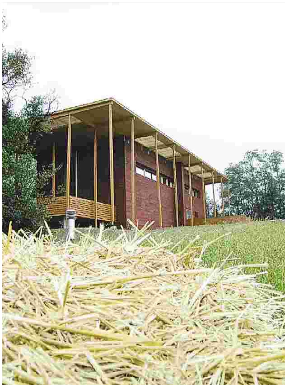
Ein schönes Naturprodukt: Das so genannte S-House in Wien wurde unter anderem mit viel Stroh gebaut.
